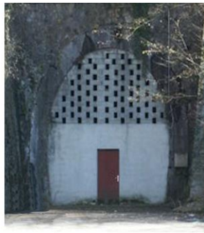
Tête de tunnel faubourg des Balmettes à Annecy
