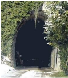
Tête de tunnel au nord de Sevrier Beau-Rivage
