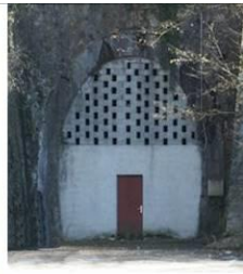
Tête de tunnel faubourg des Balmettes à Annecy
